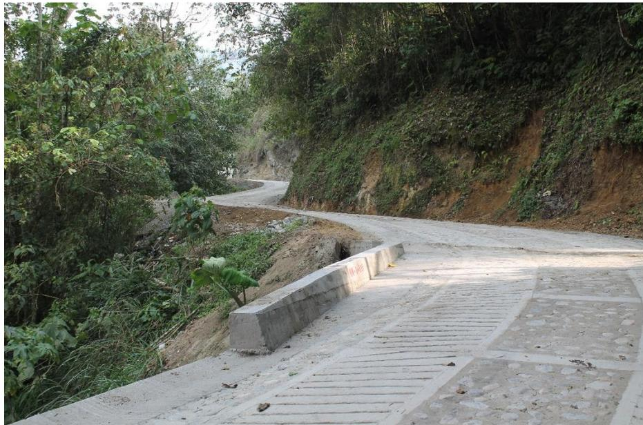
CONSTRUCCION DE HUELLA O PLACA HUELLA EN CONCRETO L= 180 MTS
