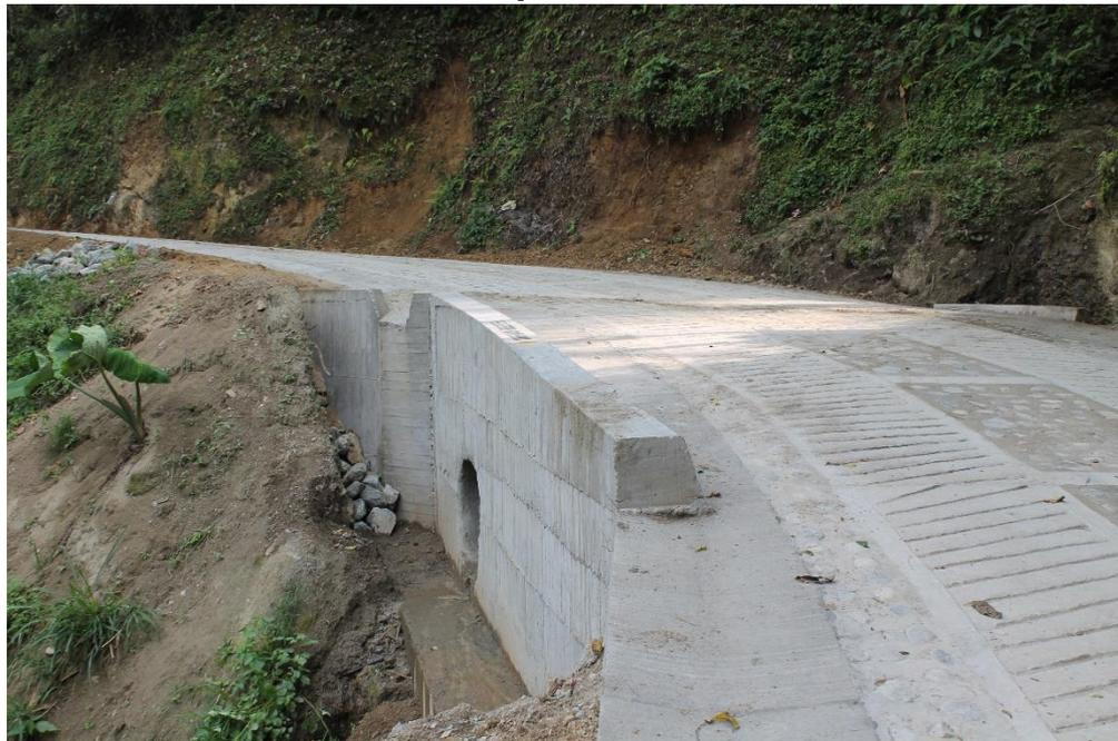
CONSTRUCCION DE ALCANTARILLAS 36" . TOTAL CONSTRUIDAS= 18
