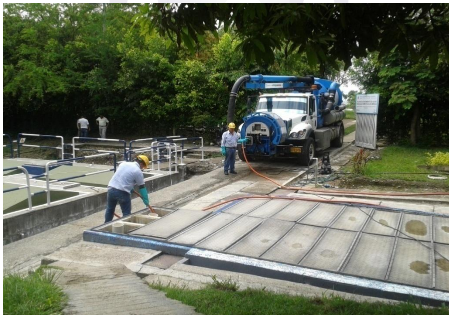
Foto 31. Retiro de material de trampas de grasa con ayuda del vector
