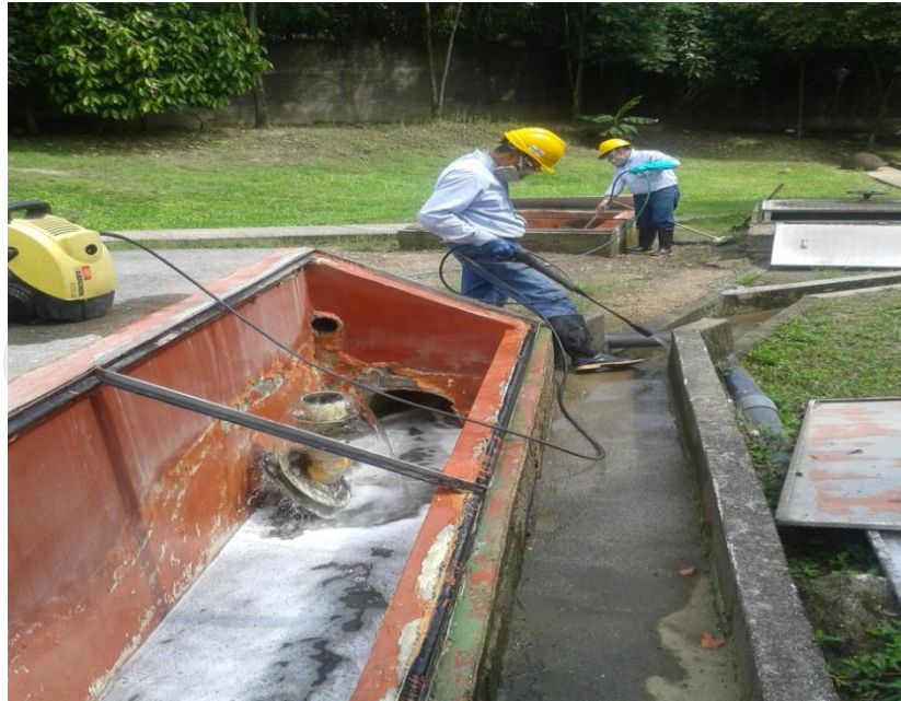
Foto 16. Lavado de las cámaras de Bypass
