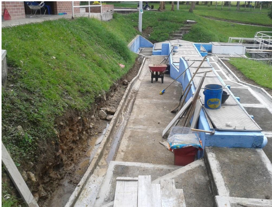
Foto 46. Construcción vertederos de salida.
