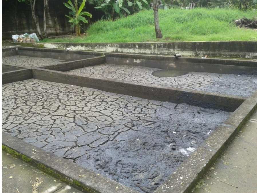
Foto 23. Disposición de lodos en los lechos de secado
