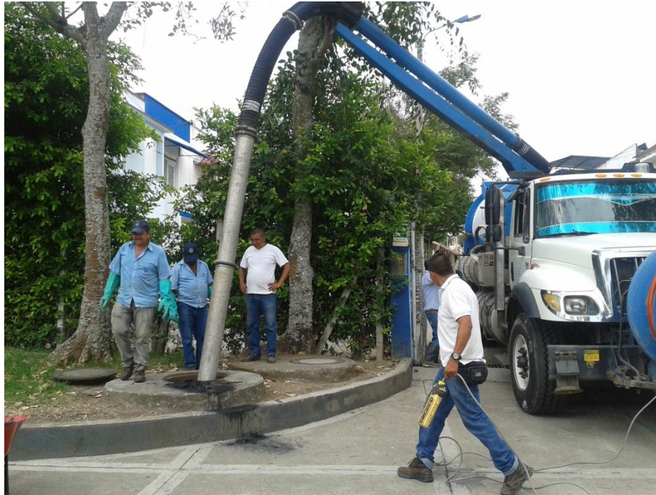
Foto 44 Lavado y mantenimiento de cajas
