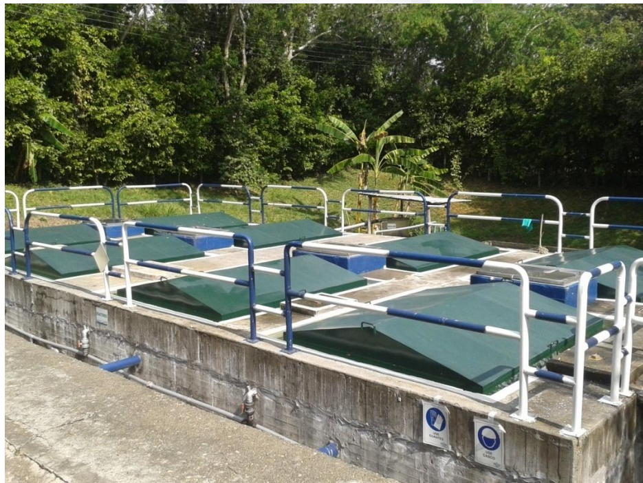
Foto 38. Después de la Rehabilitación
