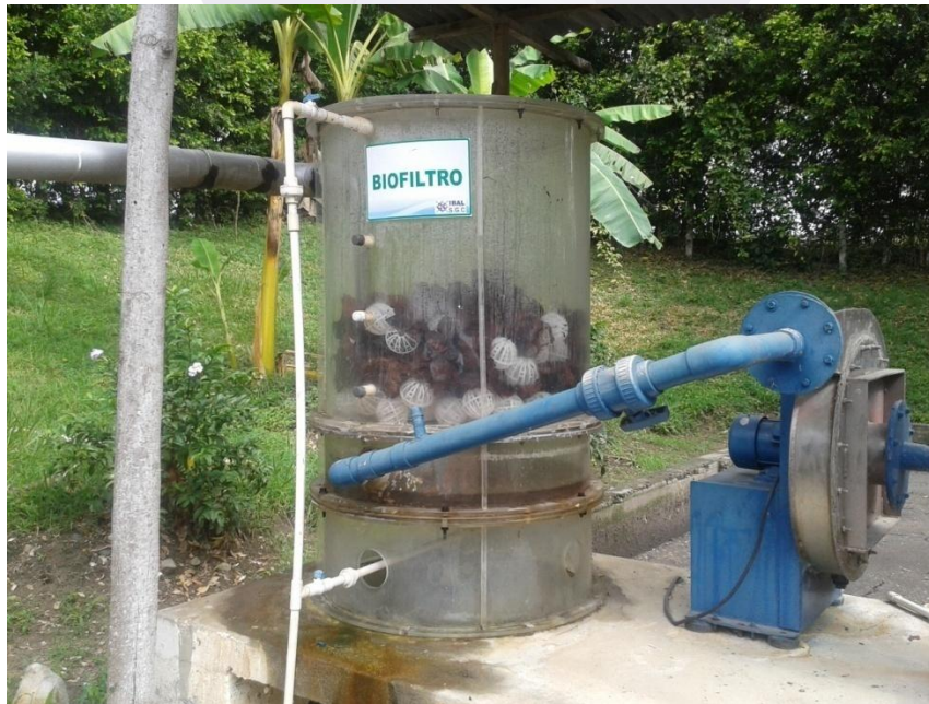
Foto 35. Revisión del Biofiltro
