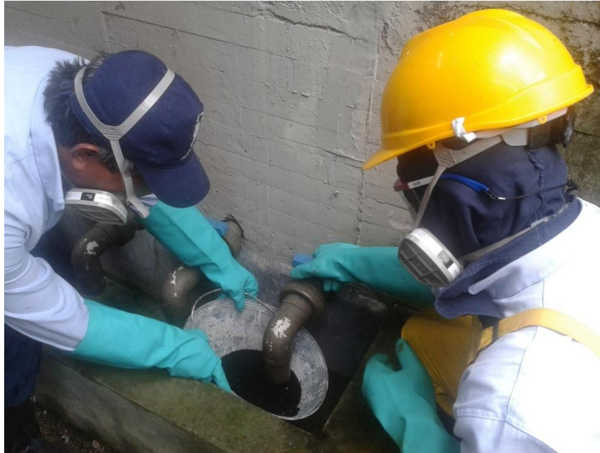
Foto 18. Reparación de los tubos de las motobombas sumergibles
