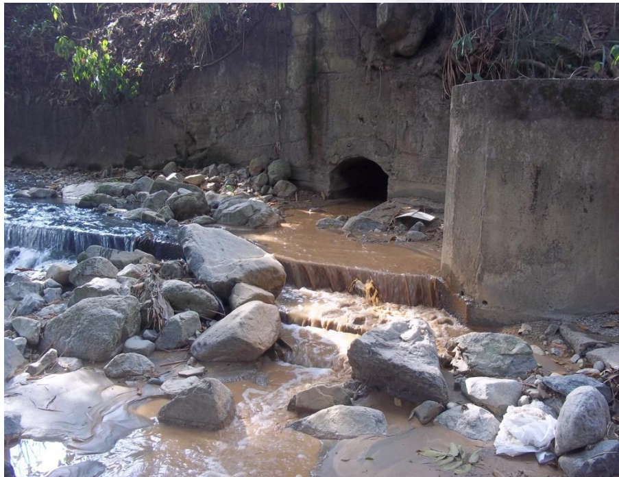
Foto 26. Contaminación del Quebrada Arenosa por procesos industriales de ladrilleras
