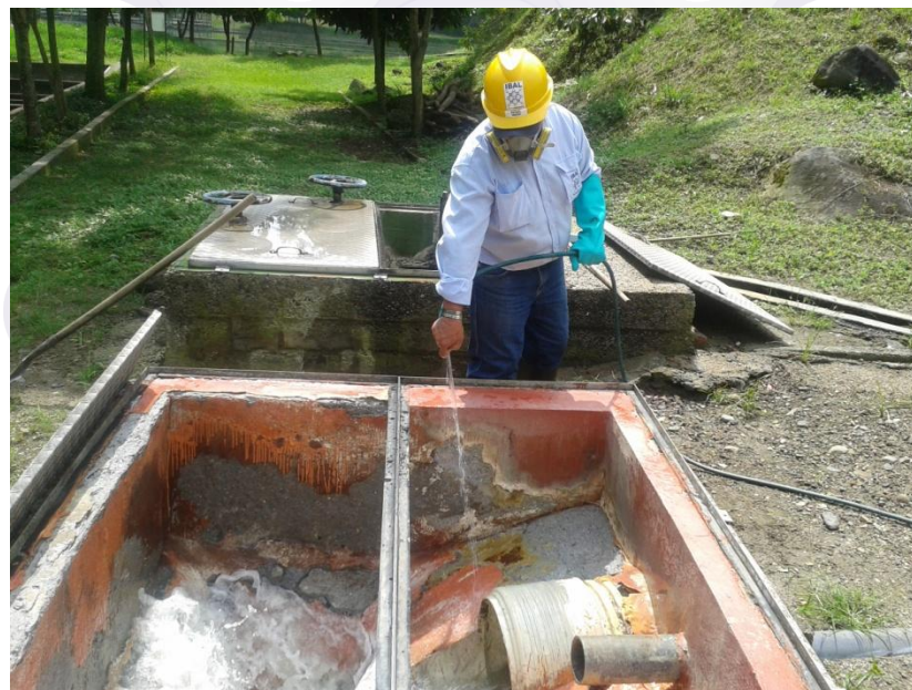
Foto 16. Lavado de las cámaras de Bypass
