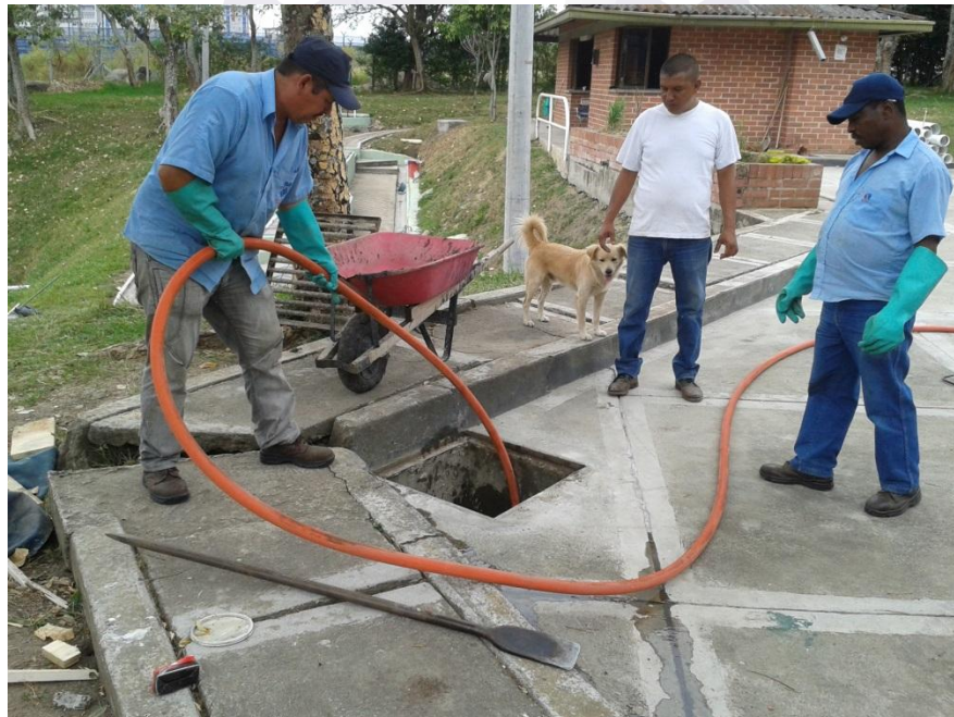
Foto 44 Lavado y mantenimiento de cajas
