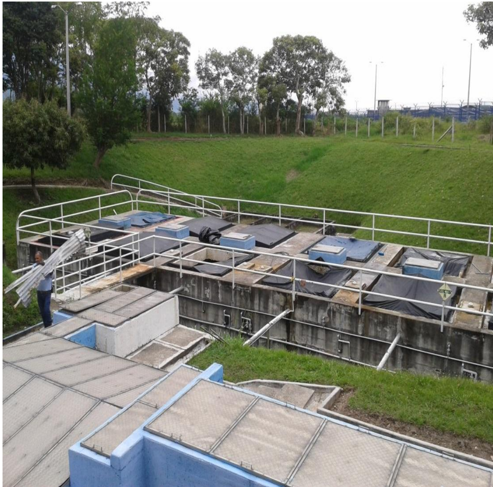
Fotos 47. Después de la Rehabilitación
