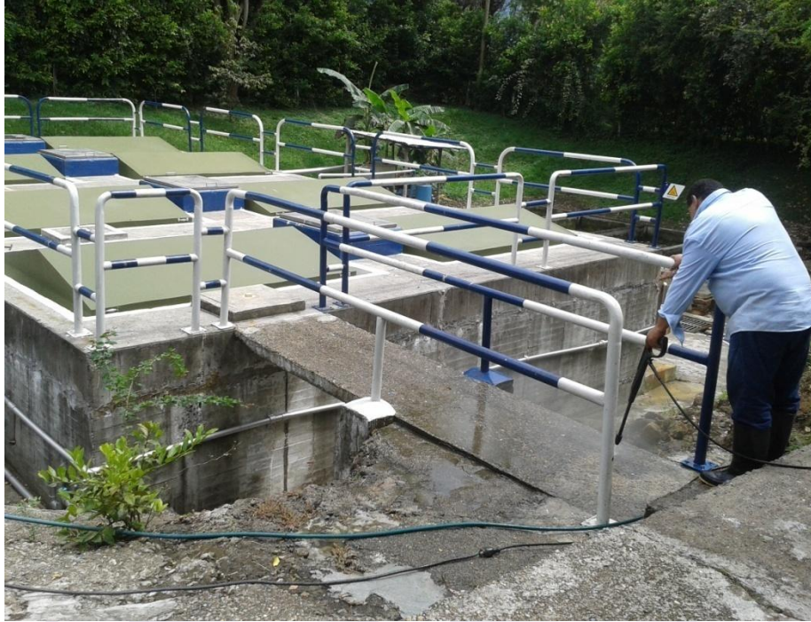
Foto 31. Retiro de material de trampas de grasa con ayuda del vector
