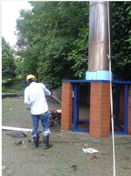
Foto 22. Revisión y limpieza de Tea Quemador
