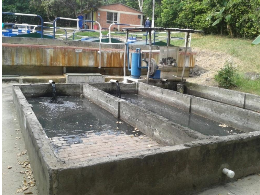
Foto 33. Canalización entrada PTARD
