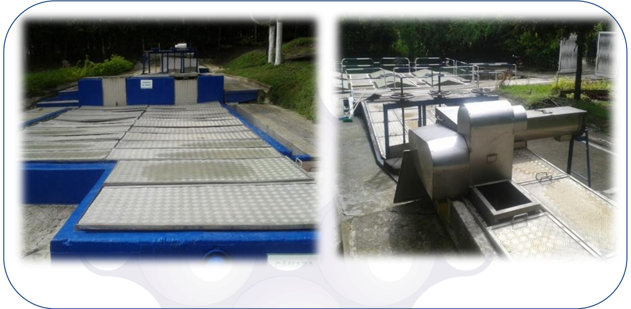
Foto 8. Sistema Preliminar – Tronillo sin Fin
