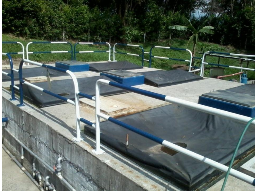
Foto 37. Antes de la Rehabilitación
