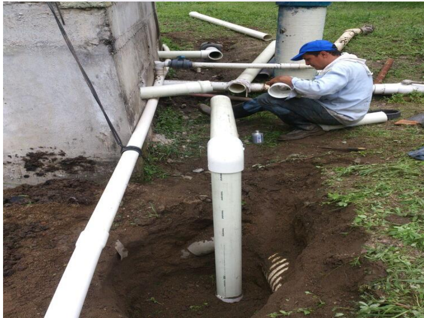
Foto 18. Reparación de los tubos de las motobombas sumergibles
