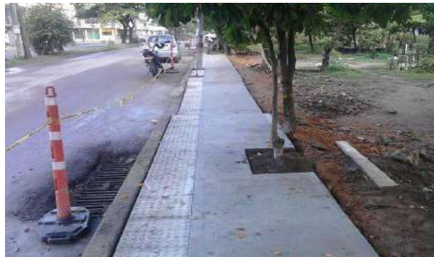
Recuperación de andenes
