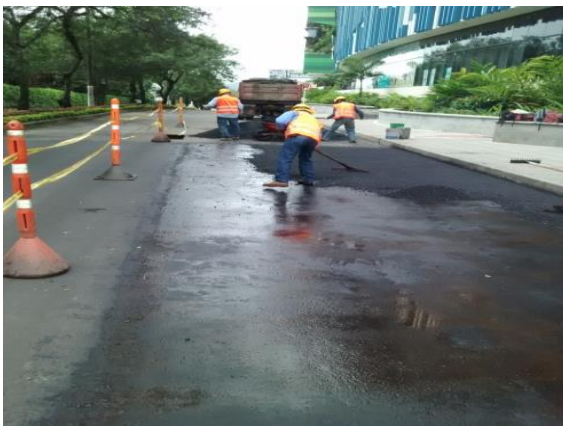
Calle 60 entre carreras 8 y 9
