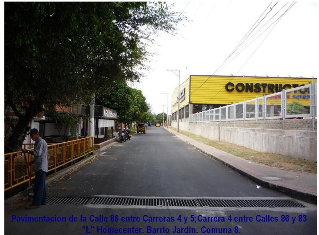
Pavimentación de la Calle 86 entre Carreras 4 y 5; Carrera 4 entre Calles 86 y 83 "L" Homecenter. Barrio Jardin. Comuna 8.
