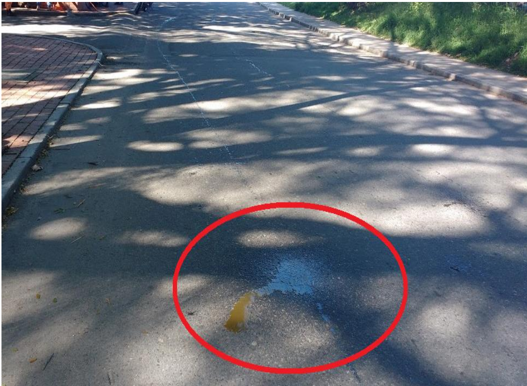
Fotografía 3. Vertimiento de lixiviados en el pavimento
