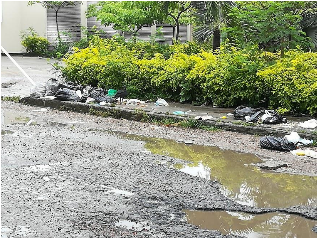
Fotografía 3. Residuos sólidos de las zonas peatonales "Barrio Mirador de Ambalá"
