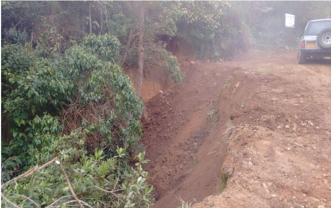
**Fotografía 2.** Cobertura con material terreo en Punto crítico identificado en la vereda Aures
