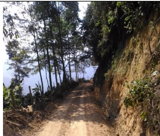
Mejoramiento y mantenimiento vía vereda San Francisco – Charco Rico. Después
