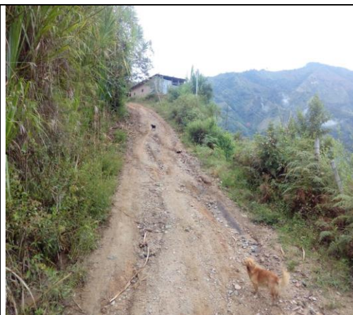
Mejoramiento y mantenimiento vía vereda San Cristobal. Antes
