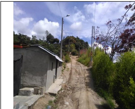
Mejoramiento y mantenimiento vía vereda el Cural. Antes
