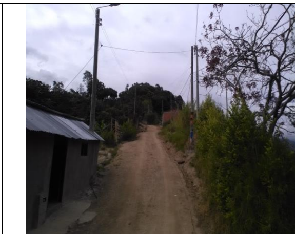
Mejoramiento y mantenimiento vía vereda el Cural. Después
