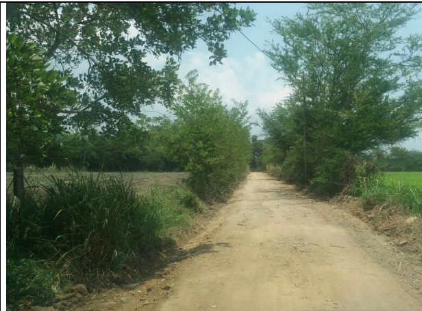
Mejoramiento y mantenimiento vía vereda la Miel
