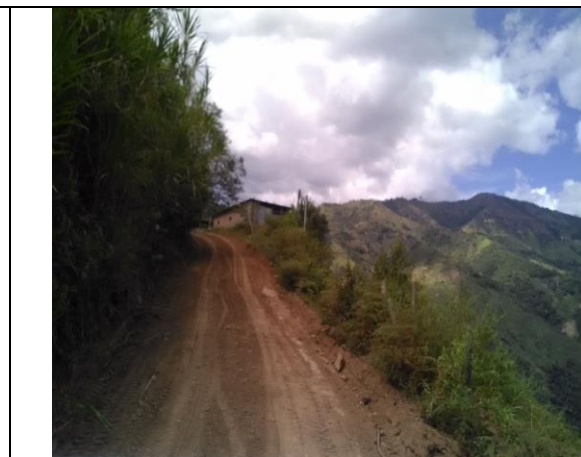
Mejoramiento y mantenimiento vía vereda San Cristobal. Después
