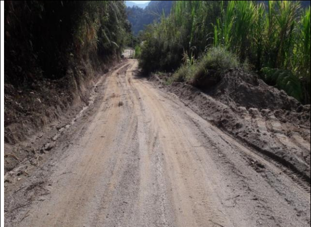
Mejoramiento y mantenimiento vía vereda Ámbala – China Alta. Después
