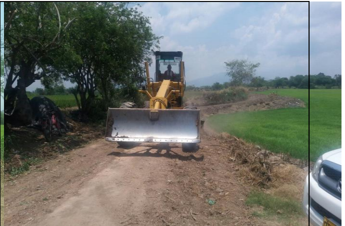
Mejoramiento y mantenimiento vía vereda la Miel.
