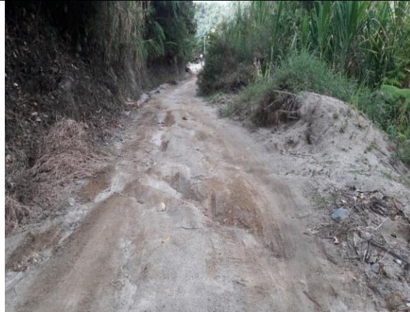
Mejoramiento y mantenimiento vía vereda Ámbala – China Alta. Antes
