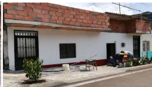
Despues de la intervención
