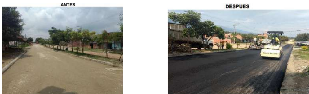
Construcción malla vial urbana Urbanización Nueva Castilla Calle 123 entre Carrera 4 y 4G
