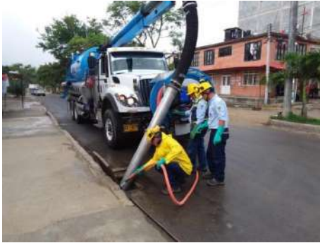
Mantenimiento y limpieza de redes de alcantarillado. PEPA
