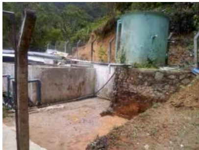
Construcción planta de tratamiento Calambeo
