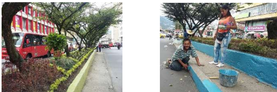
Embellencimientos separadores Calle 15.
