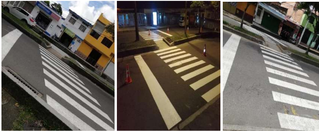
Pasos peatonales Hospital San Francisco.
