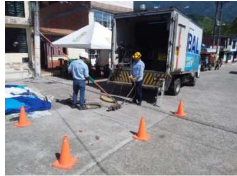
Mantenimiento y limpieza de redes de alcantarillado. PEPA
