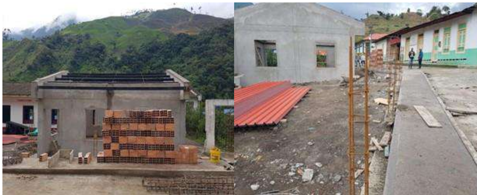
Institución Educativa Tapias sede Toche. Construcción de aula, biblioteca, cerramiento, adecuación de batería sanitaria, cambio de cubierta, cambio de pisos y pintura general.
