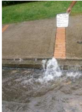
Reparaciones puntuales de daños y recuperaciones de la red de acueducto daño en Red matriz acueducto. Apartamentos Multicentro Jordán Et I.
