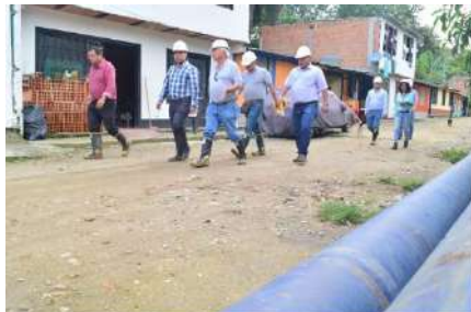
Tanque zona industrial
