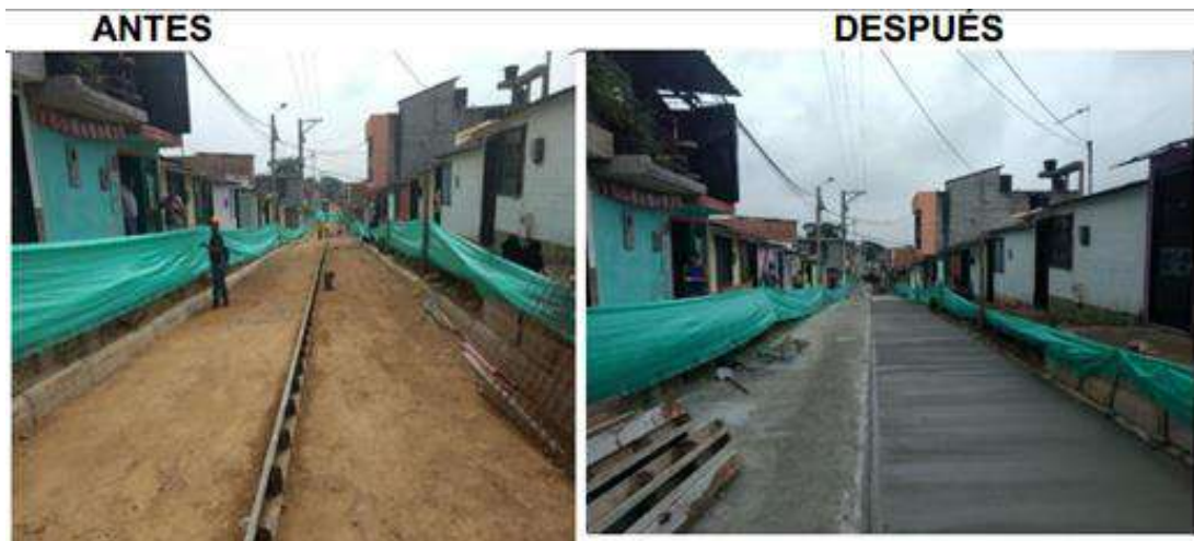
Construcción malla vial urbana Urbanización Nueva Castilla Carrera 4 entre Calle 122 y Calle 123
