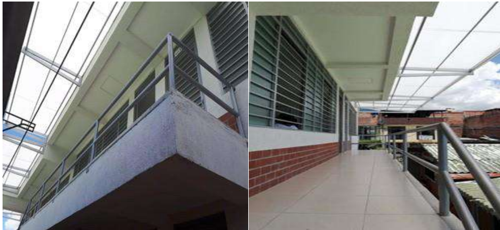
Obra IE Maximiliano Neira Lamus. Instalación de pisos, cielo raso, vidrios, pañete y pintura, instalaciones eléctricas y parasoles
