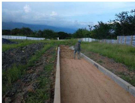
Construcción parque recreo deportivo Santa Rita
