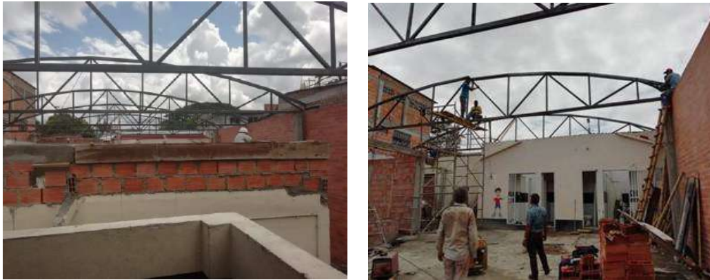
Institución Educativa José Joaquín Flórez Hernández sede Escuela Mixta Picaña. Construcción de cubierta, ampliación de comedor – cocina, y adecuaciones de aulas.
