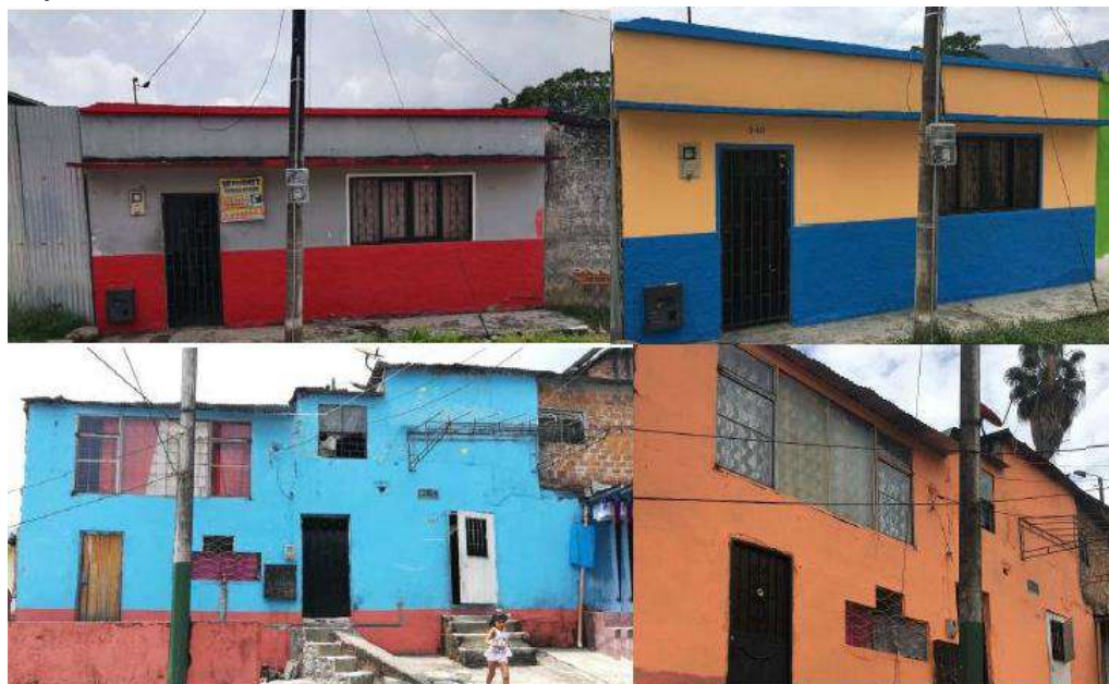
Mejoramiento urbano a través de pintura fachadas B/Industrial
