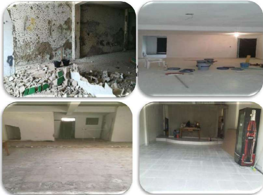
Adecuación de equipamientos barrio La Libertad y San Diego
