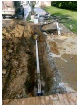
Reparaciones puntuales de daños y recuperaciones de la red de acueducto daño en Red matriz acueducto. Apartamentos Multicentro Jordán Et I.
