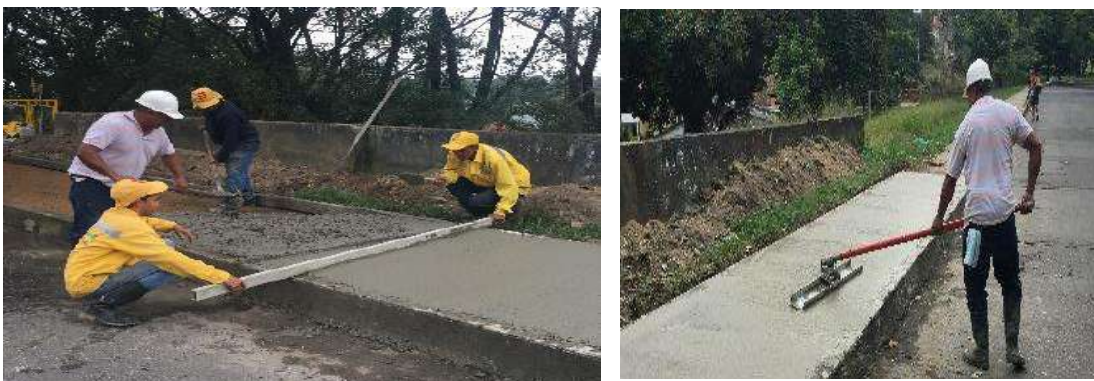
Construcción andenes Villa Martha Av. Ambala entre Calles 103 y 104. Comuna 7
