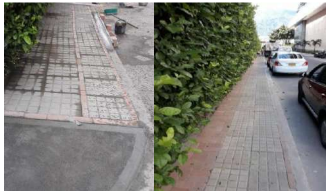
Rehabilitación andenes Toscana CC Acqua
