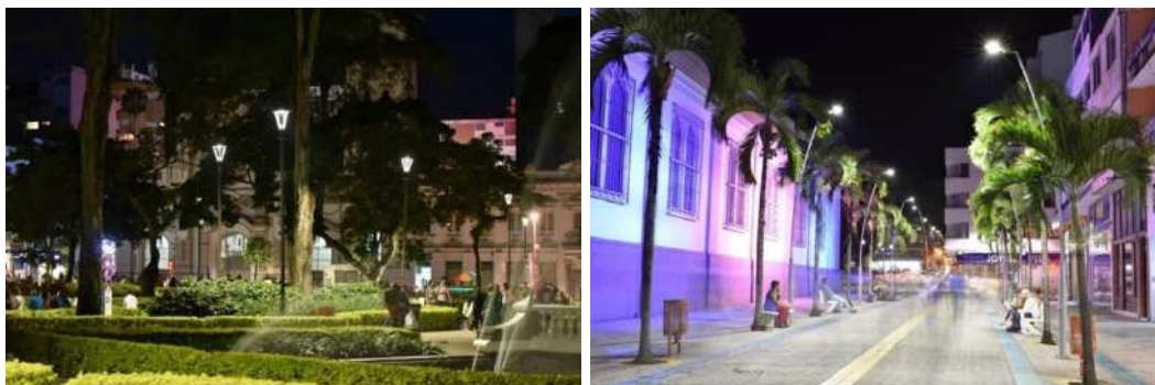
Instalación de luminarias Plaza de Bolívar y Carrera 3.
