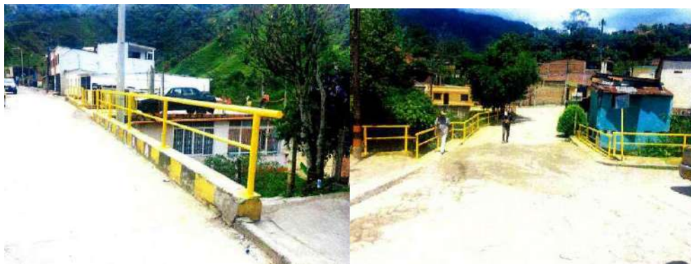
Suministro e instalación baranda de tipo peatonal, en puente vehicular para seguridad y protección del tránsito vehicular y peatonal
