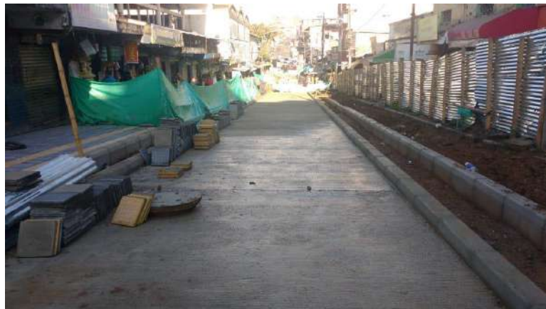
Obras de recuperación de espacio público plaza de la 21
