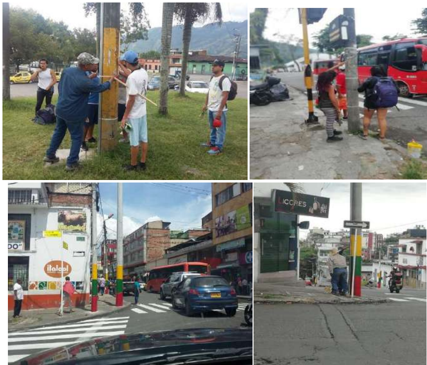
Mejoramiento urbano a través de pintura postes zona centro
