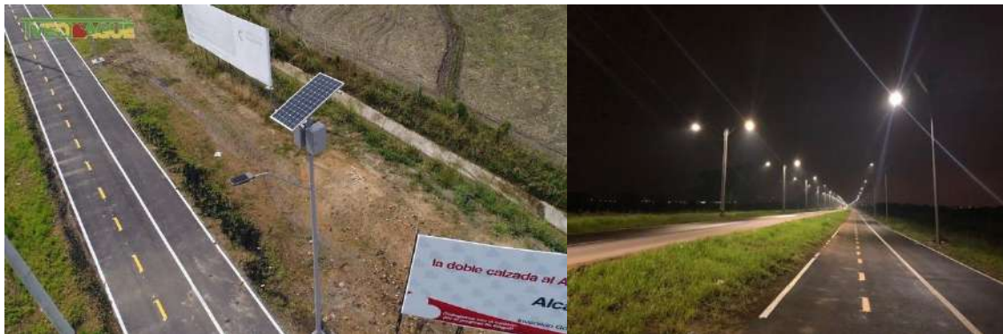
Paneles solares Cicloruta
