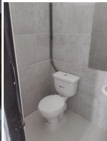
Suministro e instalación de carpintería en aluminio. Enchape de baño con suministro e instalación de inodoro y lavamanos.
