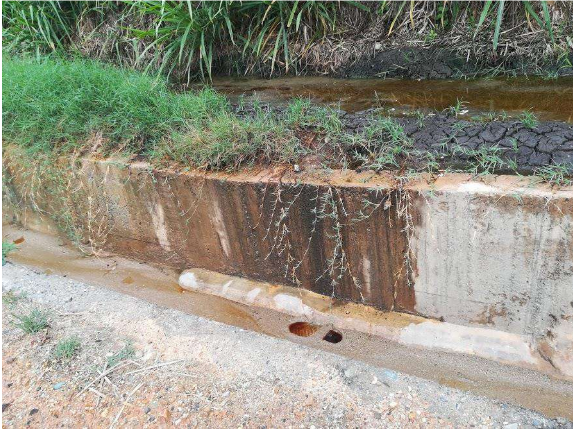
Fotografía 14. Presencia de lixiviados en los canales de aguas lluvias
