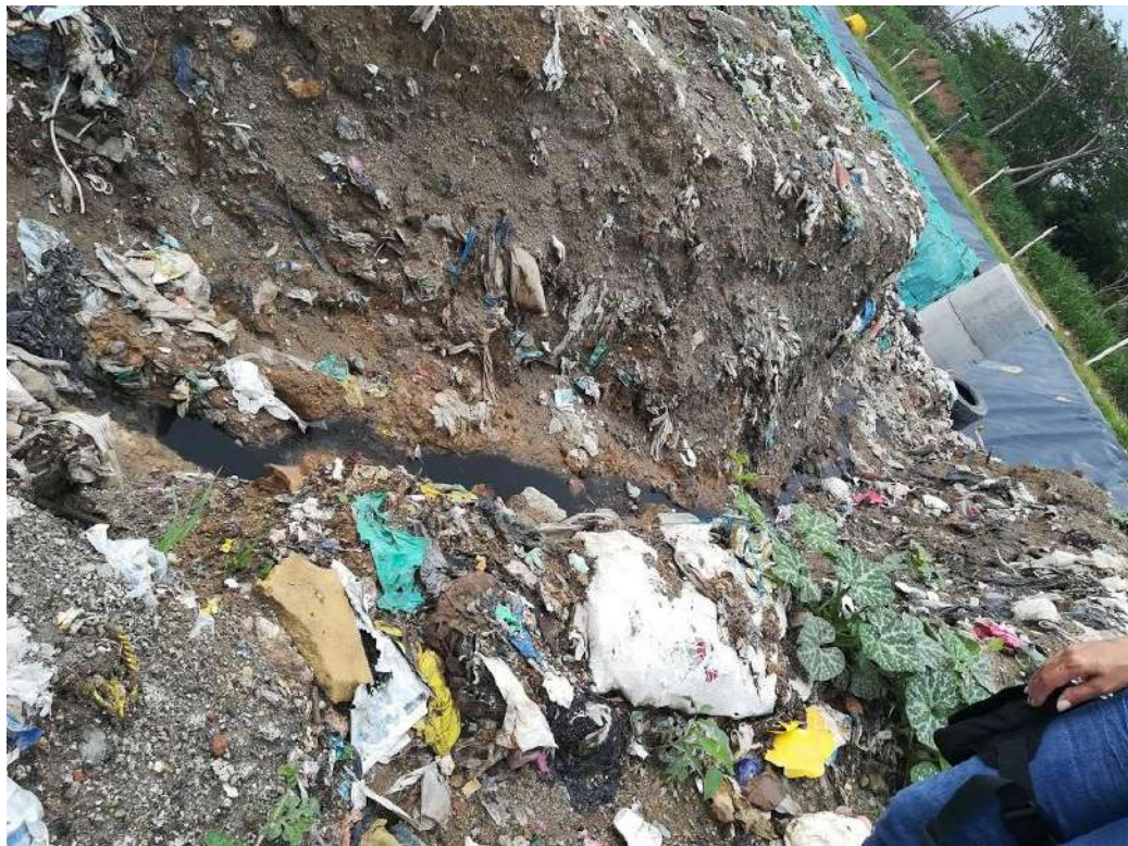
Fotografía 7. Canalización de lixiviados
