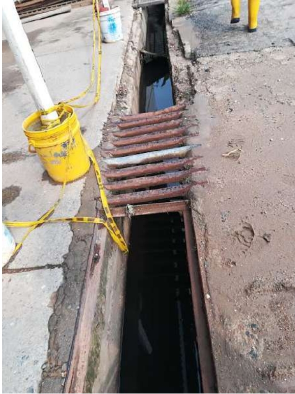
Fotografía 3. Canales de aguas lluvias con presencia de lixiviados
