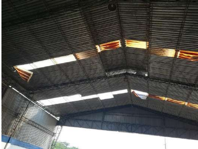
Fotografía 1. Techos de la Planta de Aprovechamiento en mal estado
