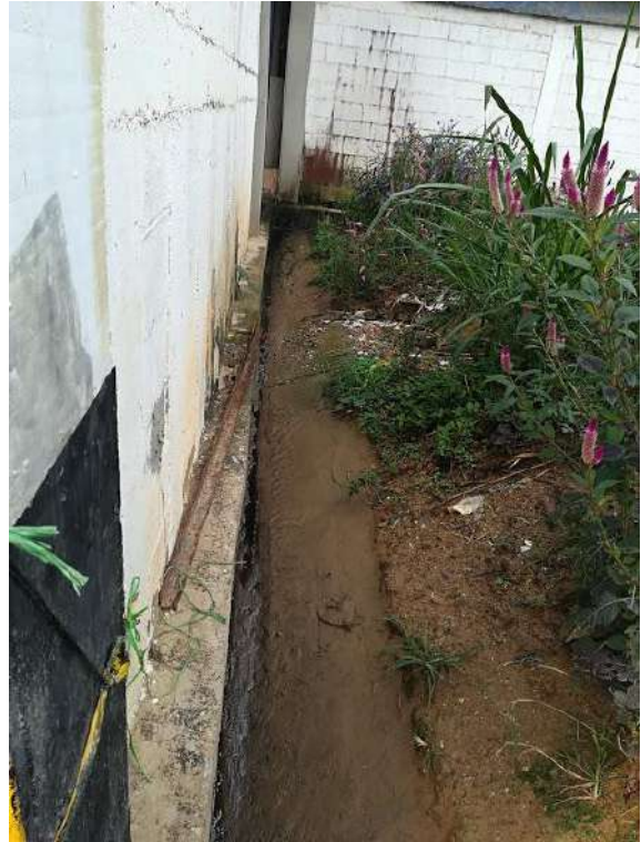
Fotografía 3. Canales de aguas lluvias con presencia de lixiviados
