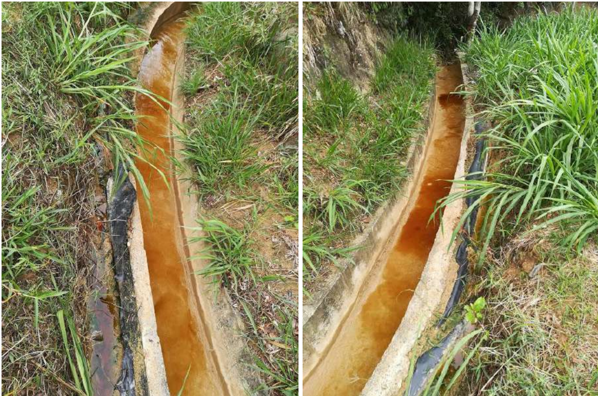
Fotografía 13. Canales de Aguas lluvias presentan lixiviados
