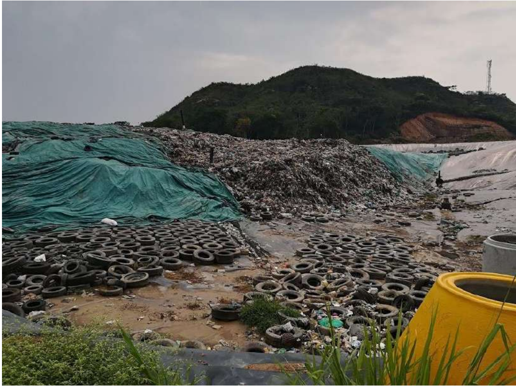
Fotografía 6. Residuos sólidos sin cobertura
