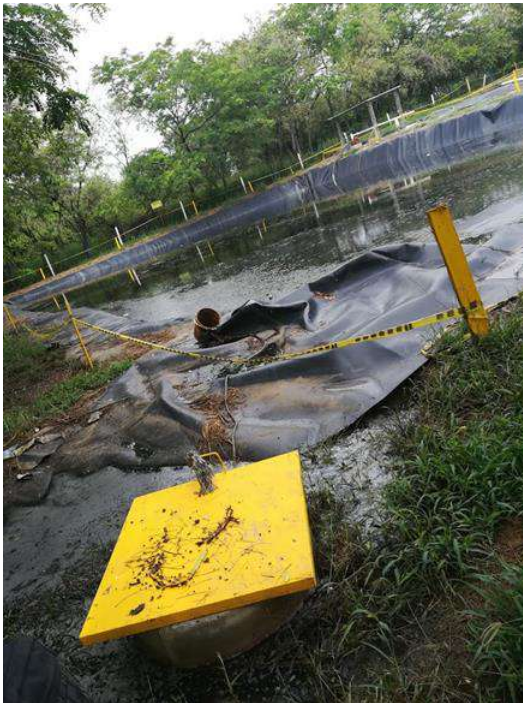
Fotografía 15. Vertimiento desde la laguna 2 hacia el terreno aledaño
