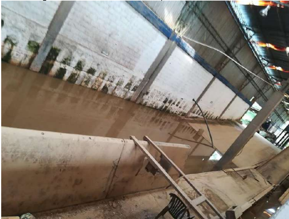
Fotografía 2. Planta de Aprovechamiento – presenta empozamiento de agua
