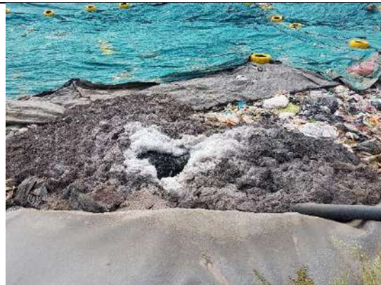
Recirculación de lixiviados
