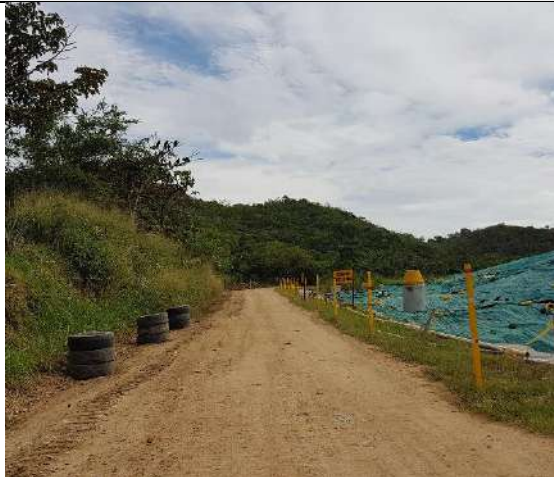
Vías de acceso a celdas de disposición
