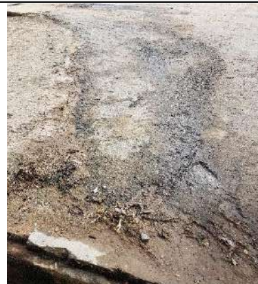
Marca de lixiviado que conduce a canal de aguas lluvias
