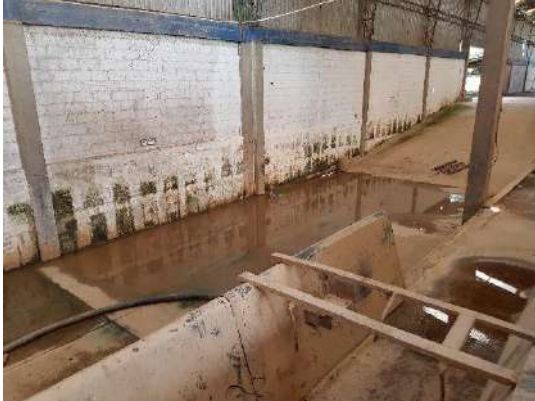
Empozamiento de Aguas Lluvias
