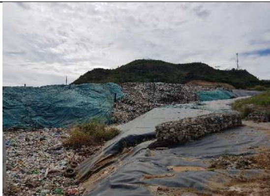
Residuos sin cobertura
