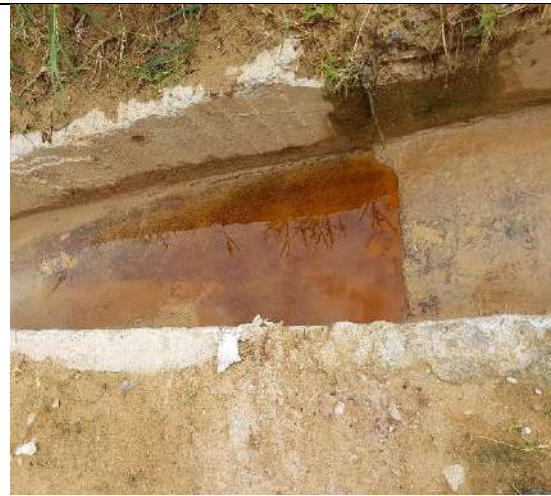
Canales de aguas lluvias
