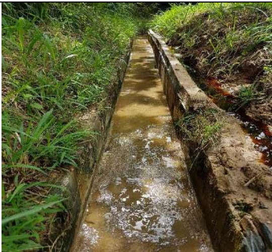
Canales de aguas lluvias
