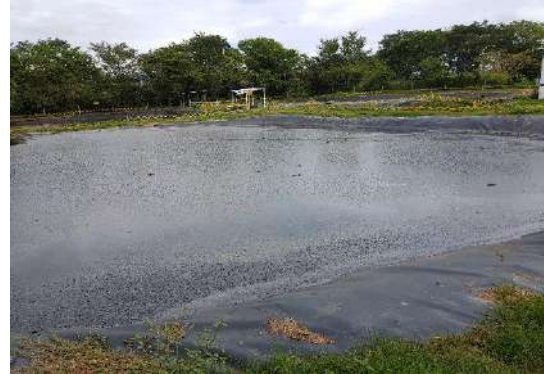
Lagunas de oxidación
