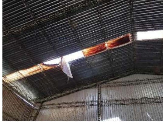
Ruptura de techos
