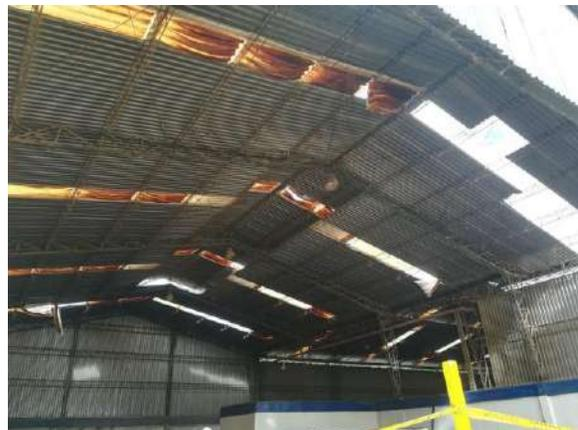
**Fotografía 2.** Retiro de Tejas - Planta de Separación
