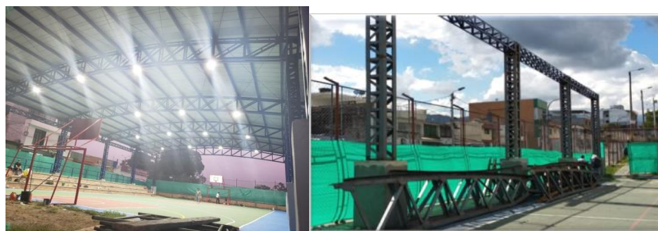
Construcción cubierta polideportivo San Cayetano
