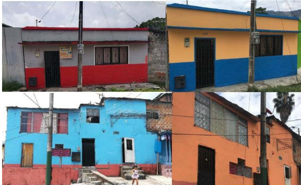
Mejoramiento urbano a través de pintura fachada B/Industrial
