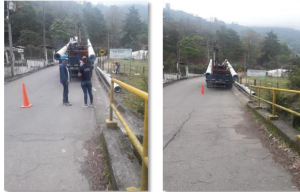
Instalación de postes para sistema de alertas tempranas
