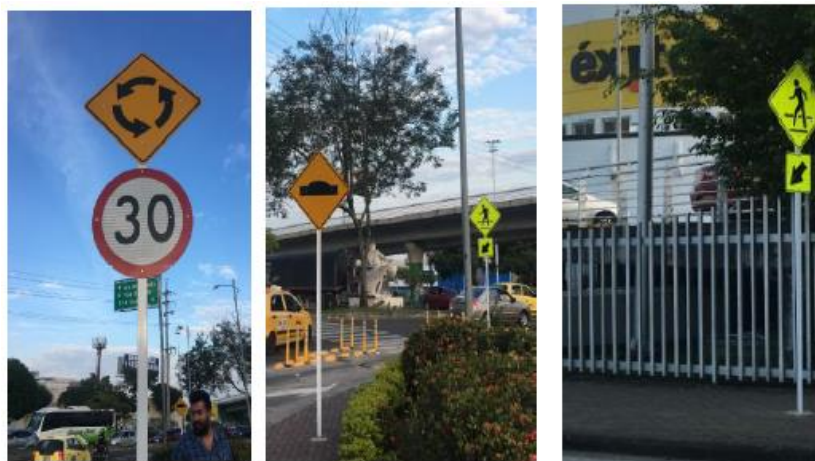
Instalación señales verticales
