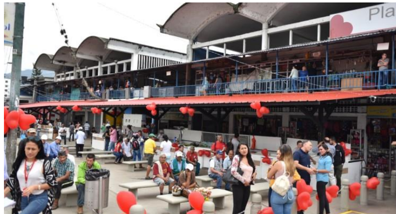
Obras de recuperación de espacio público plaza de la 21
