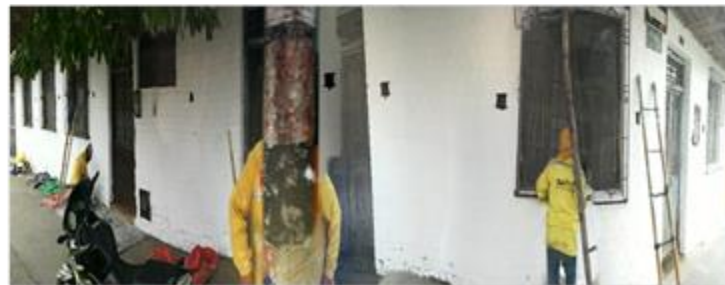
Mejoramiento urbano a través de pintura fachada barrio Claret
