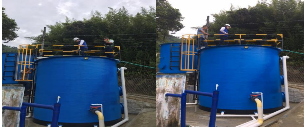
Planta de tratamiento agua potable – Vereda Calambeo
