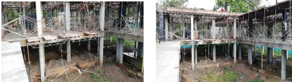
Avance de obra de I.E. corte de 15 de mayo de 2019.
