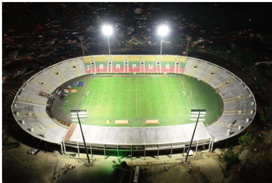
Nuevas luminarias estadio Manuel Murillo Toro
