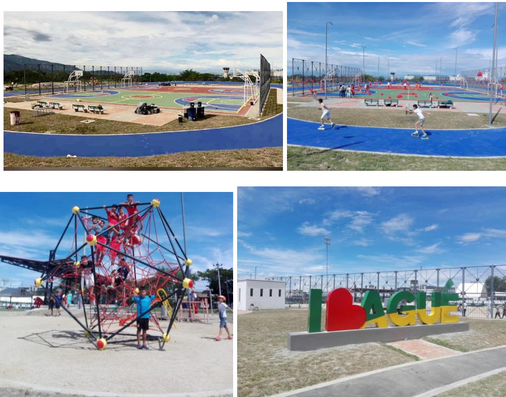
Construcción parque recreo deportivo Santa Rita
