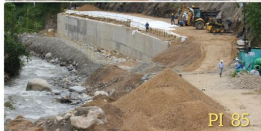
Avance del proyecto acueducto complementario
