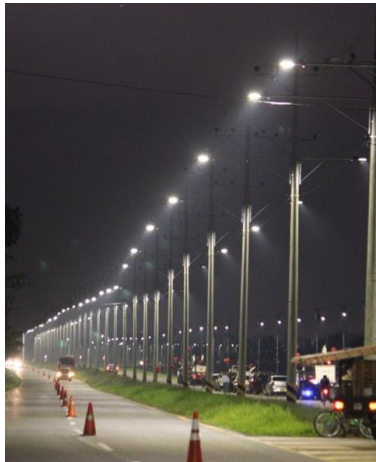
Iluminación Led doble calzada al Aeropuerto Perales
