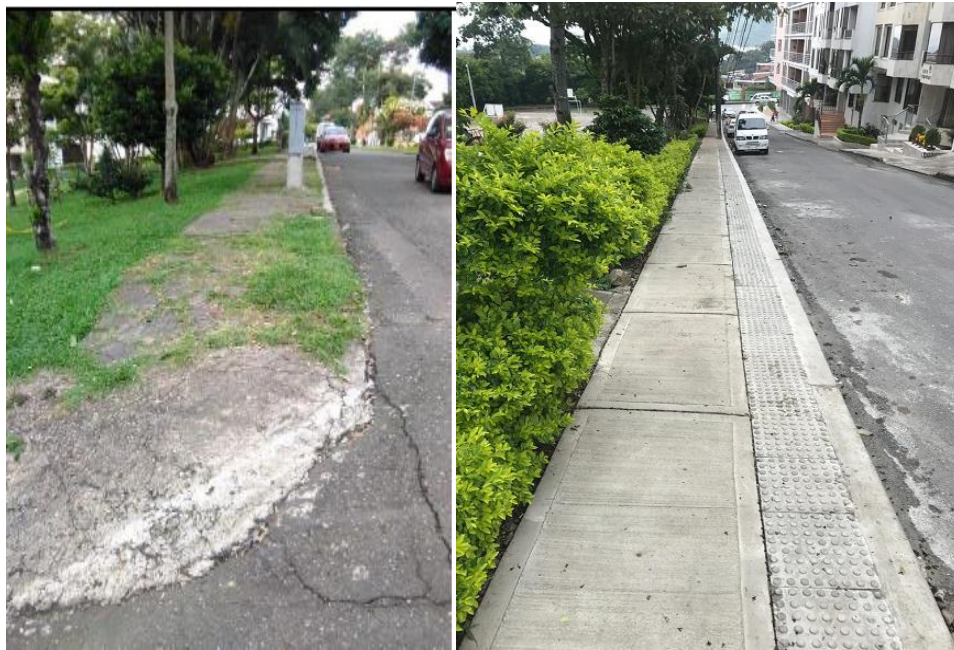
Antes y después adecuación anden parque deportivo Barrio Piedra Pintada
