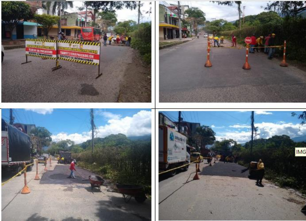
Actividades de Parcheo para la recuperación de la movilidad en la malla vial de Ibagué
