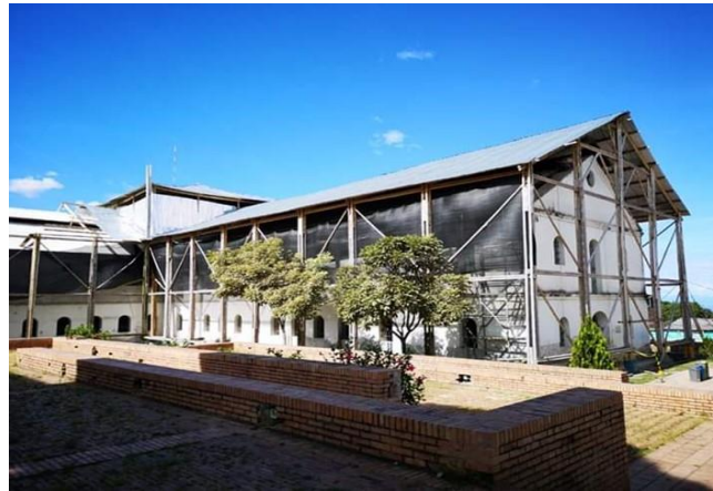
Obras Panóptico de Ibagué
