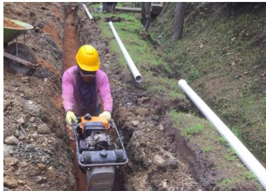
Acueducto rural de la vereda El Salitre, corregimiento Carmen de Bulira
