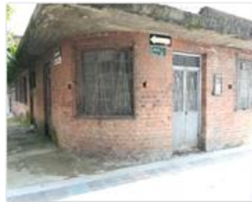
ANTES DE LA INTERVENCION
