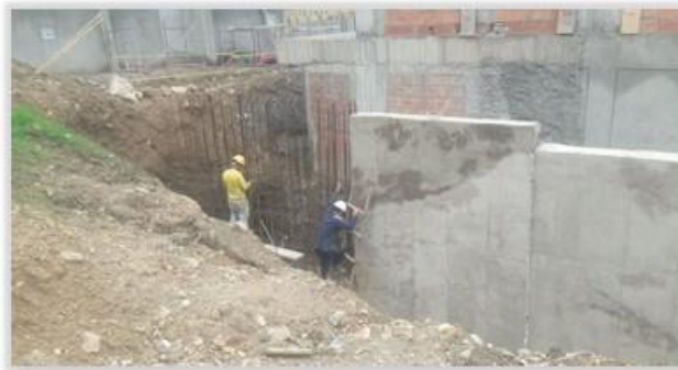
Ejecución de obra IE Ambiental Combeima
