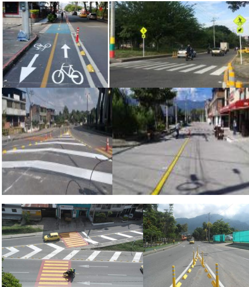
Dispositivos para el control de tránsito
