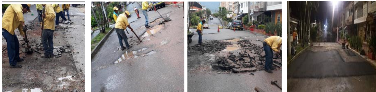
Sectores de las distintas comunas de la ciudad, malla vial mejorada y rehabilitada
