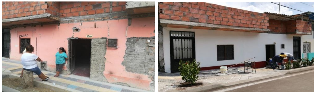
Mejoramiento urbano a través de pintura fachada barrio Claret
