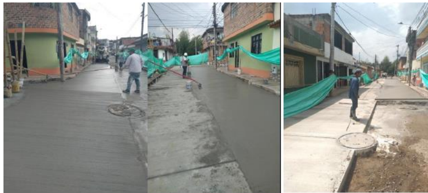
Construcción malla vial urbana carrera 15 entre calles 63 y 64 Barrio Ambala.
