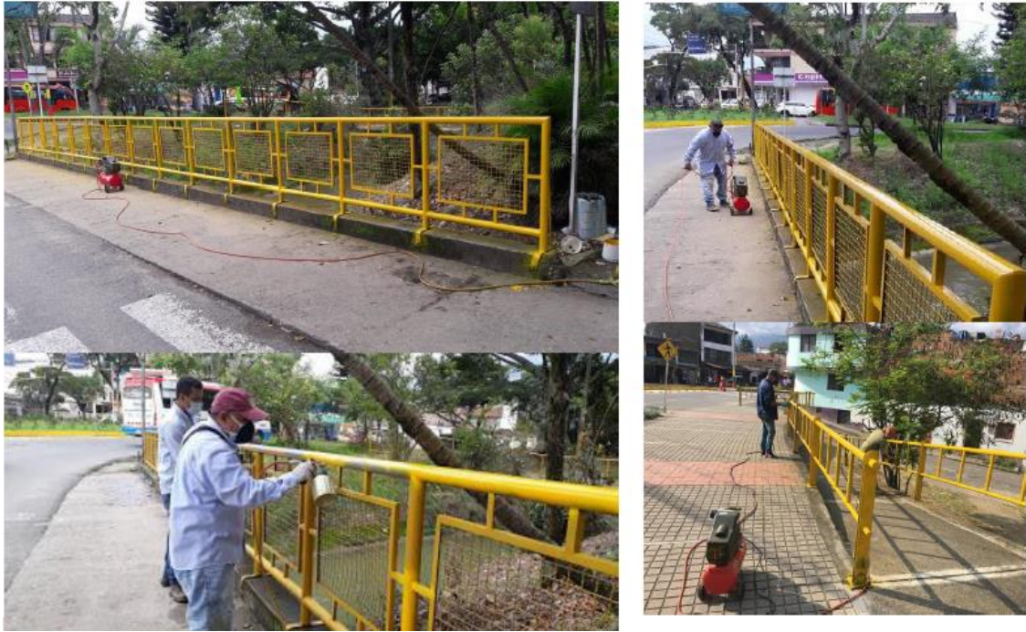
Pintura de barandas aledañas al Estadio Manuel Murillo Toro
