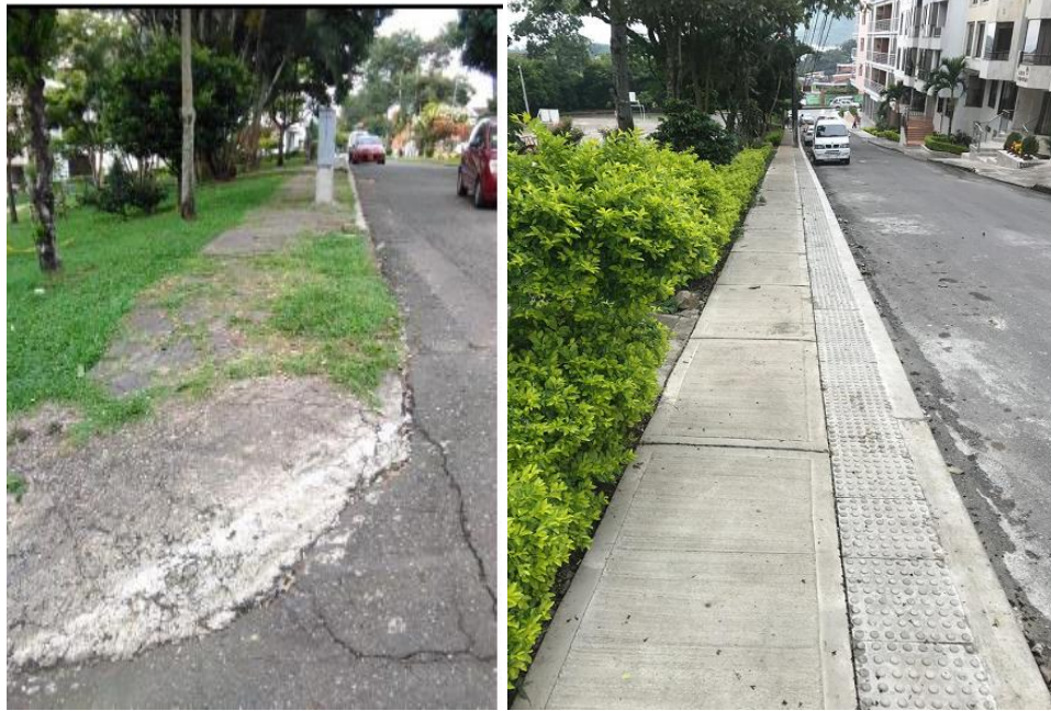
Antes y después adecuación andén parque deportivo Barrio Piedra Pintada
