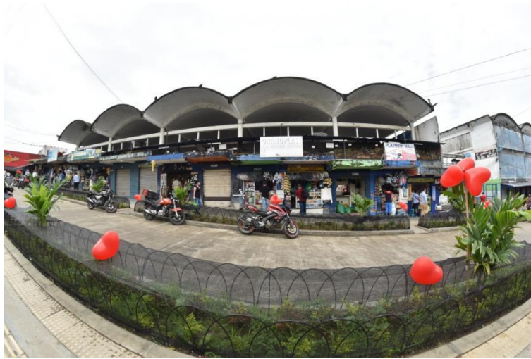
Obras de recuperación de espacio público plaza de la 21
