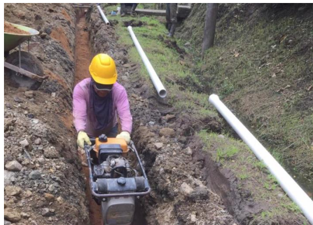
Construcción de nuevos acueductos rurales
