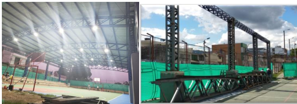
Construcción cubierta polideportivo San Cayetano
