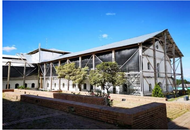
Obras Panóptico de Ibagué
