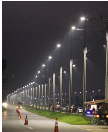
Iluminación Led doble calzada al Aeropuerto Perales
