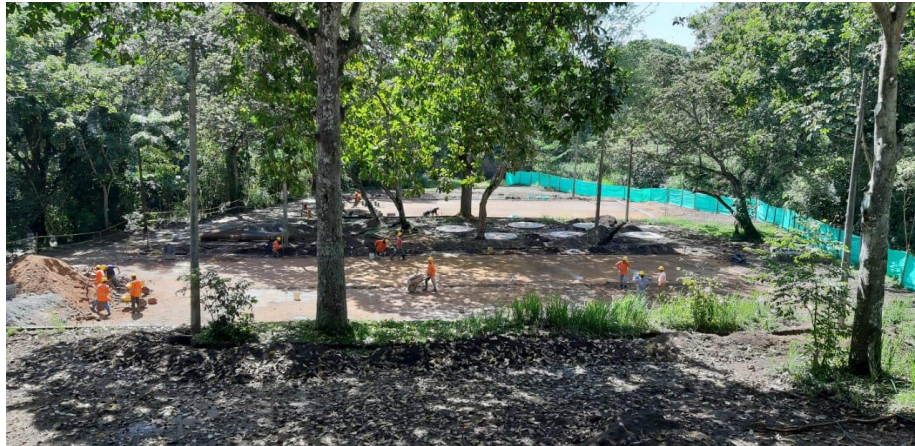
Obras actuales parque Topacio
