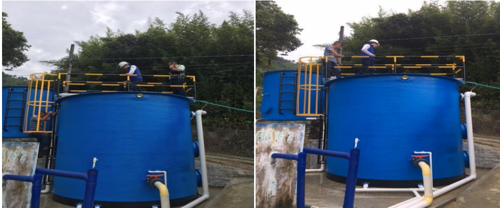
Planta de tratamiento agua potable – Vereda Calambeo
