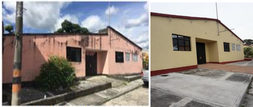
Fotos del estado del salón comunal del Barrio San simón antes y después de la intervención
