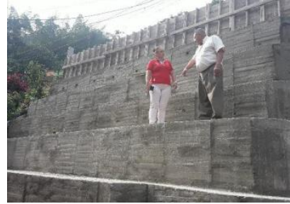
Obras de mitigación.
