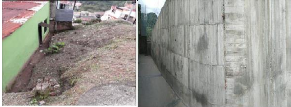
Foto antes Vs después de la construcción de muro de contención Carrera 2B N° 3 -12 Barrio Libertador
