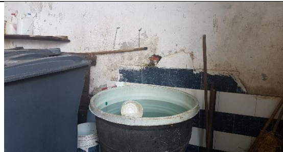
RESERVORIO DE AGUA PARA ACTIVIDADES DE LIMPIEZA
