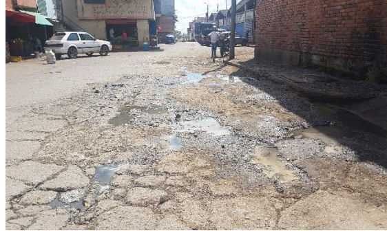
VIA DE ACCESO AL CHUTE
