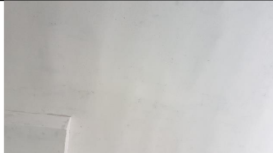
ESTADO DE TECHOS
