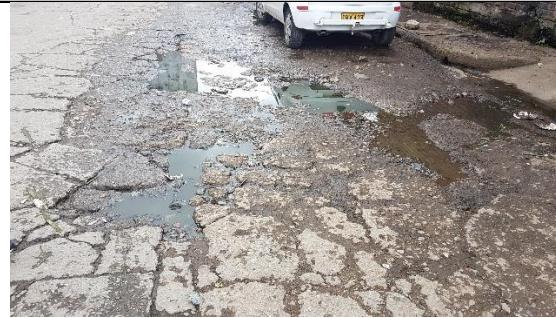
VIA DE ACCESO AL CHUTE
