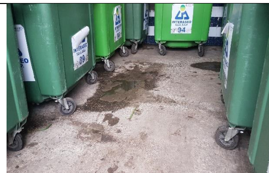
ESTADO DE LOS PISOS
