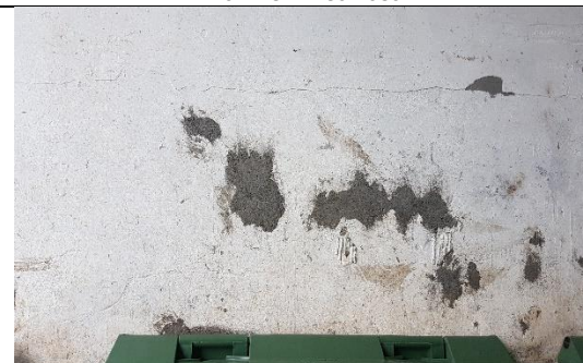
ESTADO DE PAREDES
