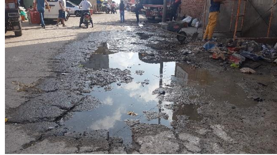
VIA DE ACCESO AL CHUTE
