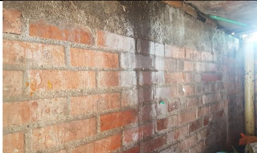
ESTADO DE PAREDES
