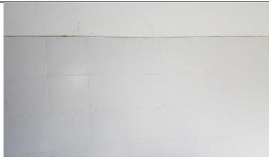
ESTADO DE LAS PAREDES
