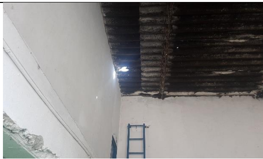
ESTADO DE LA CUBIERTA
