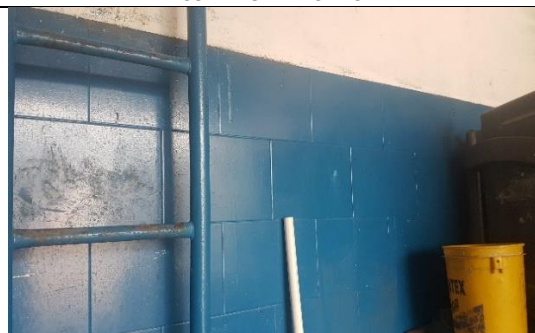
ESTADO DE LAS PAREDES
