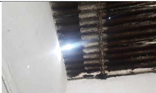
ESTADO DE CUBIERTA O TEJADO
