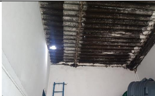
ESTADO DE CUBIERTA O TEJADO
