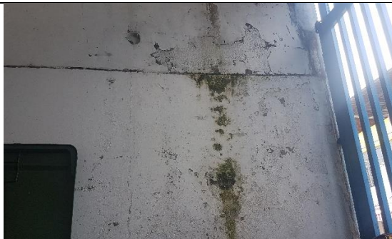
ESTADO DE PAREDES
