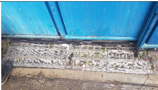
REJILLA DE RECOLECCIÓN DE AGUAS NEGRAS
