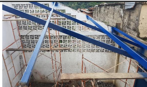
INTERVENCIÓN DEL CHUTE
