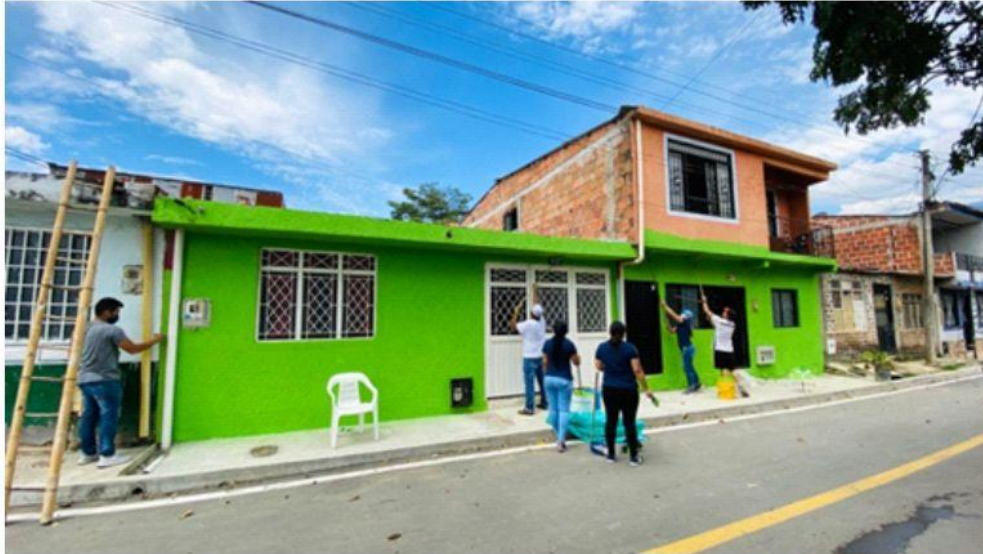
EMBELLECIMIENTO DE FACHADAS EN EL BARRIO PROTECHO SALADO
