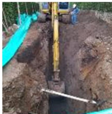
Reposición de redes de alcantarillado en las diferentes comunas
