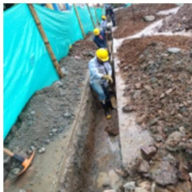
Reposición de redes de alcantarillado en las diferentes comunas
