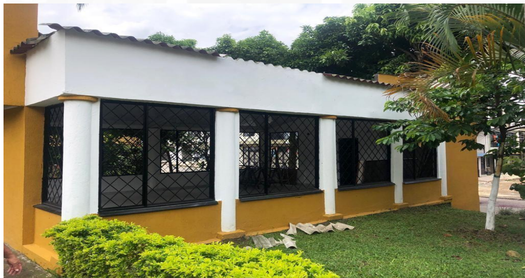
Salón Comunal Barrio Cantabria
