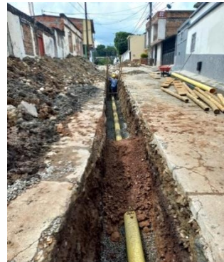
Reposición de redes de alcantarillado en las diferentes comunas
