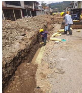
Reposición de redes de alcantarillado en las diferentes comunas
