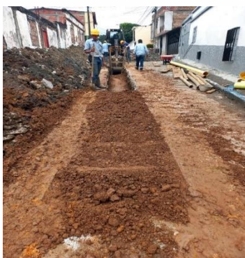
Reposición de redes de alcantarillado en las diferentes comunas
