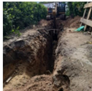
Reposición de redes de alcantarillado en las diferentes comunas
