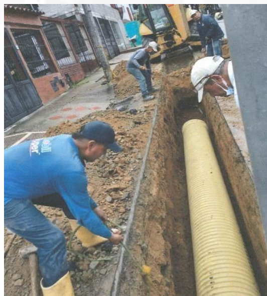
Perforaciones para la instalación de la tubería en el sector de la vereda Llanitos
