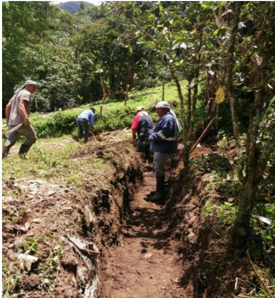
Perforaciones para la instalación de la tubería en el sector de la vereda Llanitos
