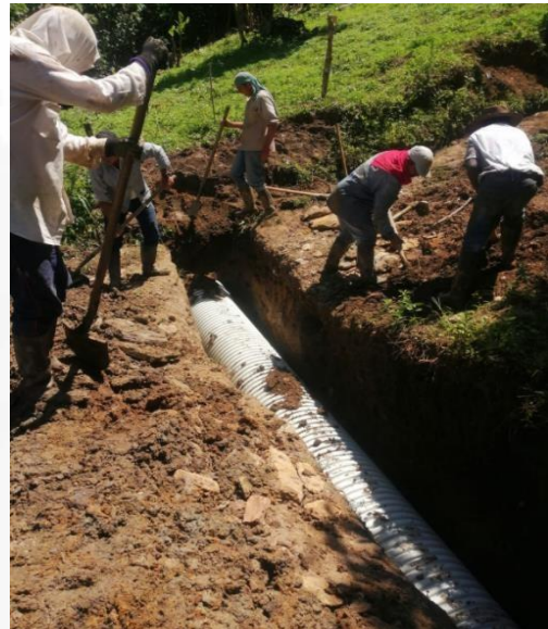
Perforaciones para la instalación de la tubería en el sector de la vereda Llanitos
