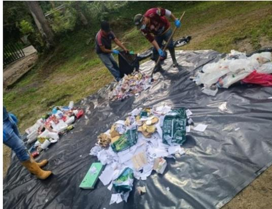
**Ilustración 4 Caracterización de residuos, cuarteo, clasificación**
